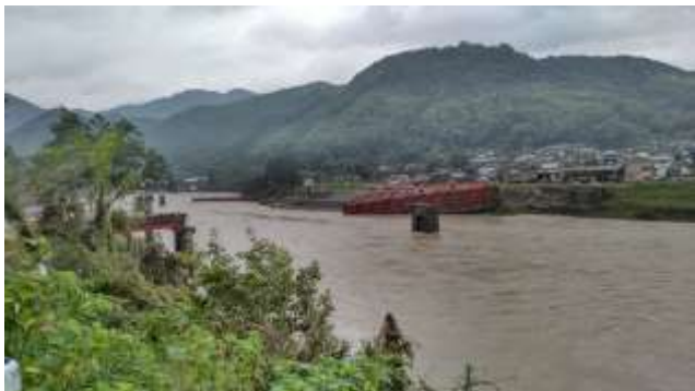
相良橋流失。すぐ目の前には渡地区。 ここが通れば人吉市まで10分なの に... (令和3年5月21日仮橋にて復旧)
