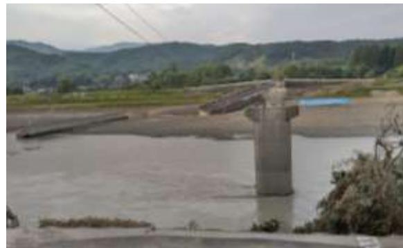
沖鶴橋流失。落ちるはずがない と誰もが思っていた橋でさえ、 流されてしまった。 復旧は4年近くかかる見込み。
